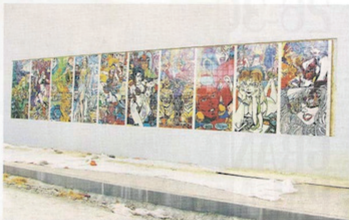
Musée Gustave Fayet (façade), Sérignan. Erró. «Femmes fatales» en cours d'installation. Céramique Work in the process of installation. Ceramic
